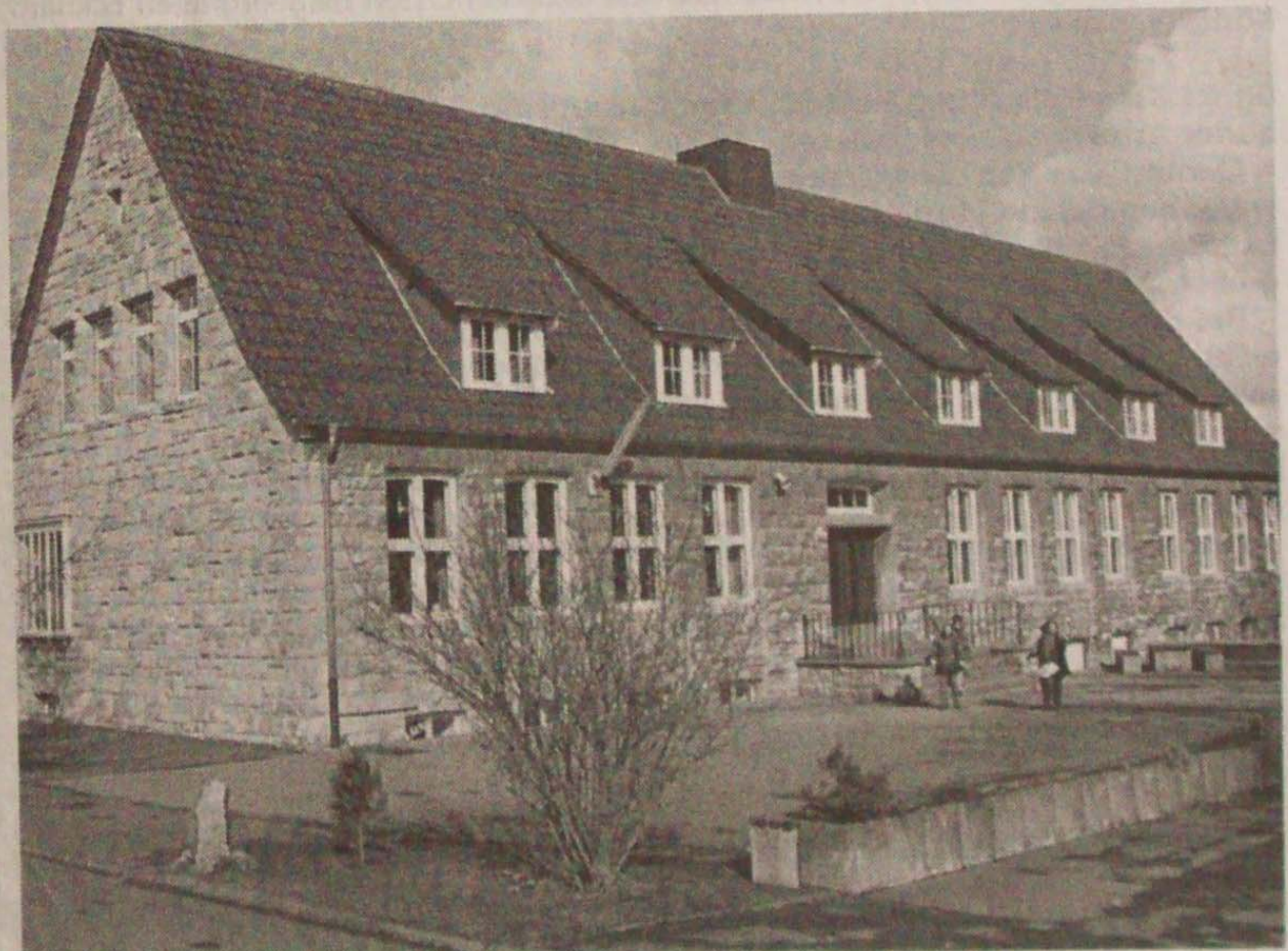
Die Grundschule in Berndorf soll noch in diesem Jahr einen Anbau mit zwei neuen Klassenräumen erhalten. (Foto: pfa)
